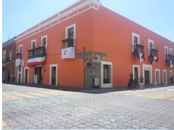
Vista exterior del edificio
